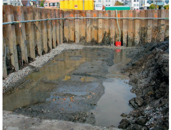
Abb. 12 Die komplette Entfernung des belasteten Materials erfolgte im Schutz einer Spundwand und bei abgesenktem Grundwasserspiegel.
