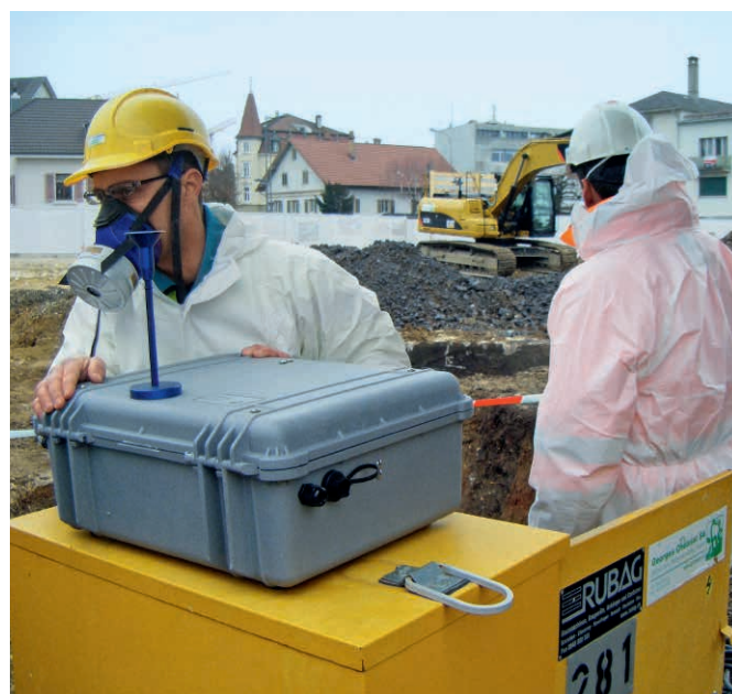
Abb. 46 Fachspezialisten in Schutzmontur auf dem Gelände der Gaswerk-Altlast in Delsberg.
