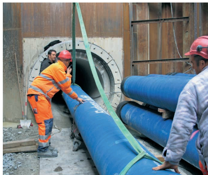
Abb. 40 Der neu erstellte Trinkwasserstollen zur Versorgung der Stadt Zürich liegt nun nicht mehr unter dem Deponiegelände.
