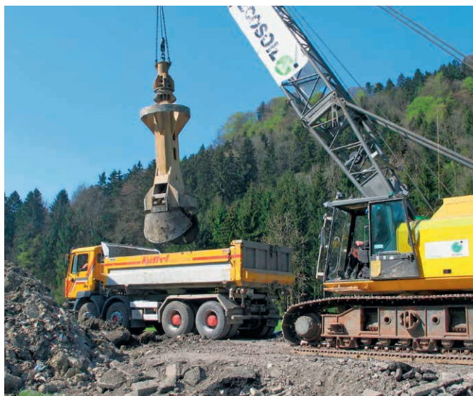
Abb. 39 Bau eines Kontrollschachts zur Untersuchung und Sanierung der Kehrichtdeponie Baarburg (ZG).
