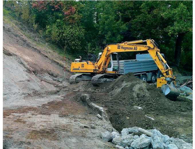
Abb. 32 Nach dem Abtrag der belasteten Bereiche ist die Nutzung des Geländes als Wies- und Weideland nun wieder uneingeschränkt möglich.
