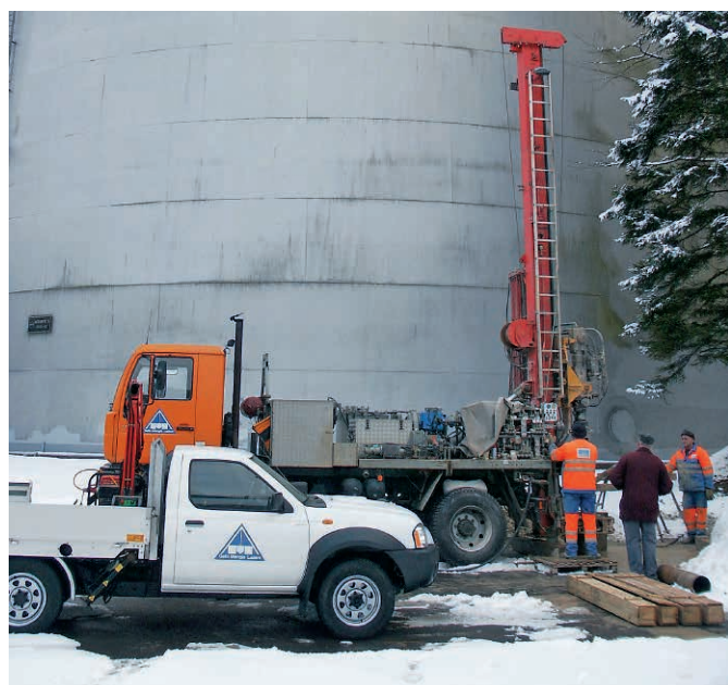
Abb. 49 Technische Untersuchung bei einem Heizöl-Tanklager in Arth-Goldau (SZ).
