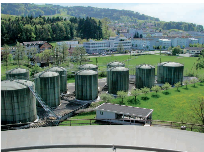
Abb.4 Die 18 600 belasteten Betriebsstandorte machen eine Fläche von schätzungsweise 60 km 2 aus.
