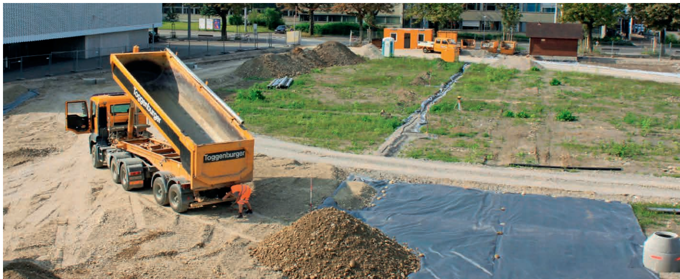
Abb. 13 Das Kleingartenareal Hard in Zürich liegt über einer früheren Deponie. Dank dem Einbau einer Trennschicht und der Überdeckung mit sauberem Bodenaushub ist die Nutzung heute problemlos möglich.
