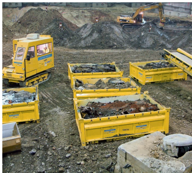
Abb. 28 Rückbau der Sondermülldeponie Kölliken (AG) in einer hermetisch von der Umwelt abgeschirmten Sanierungshalle.
