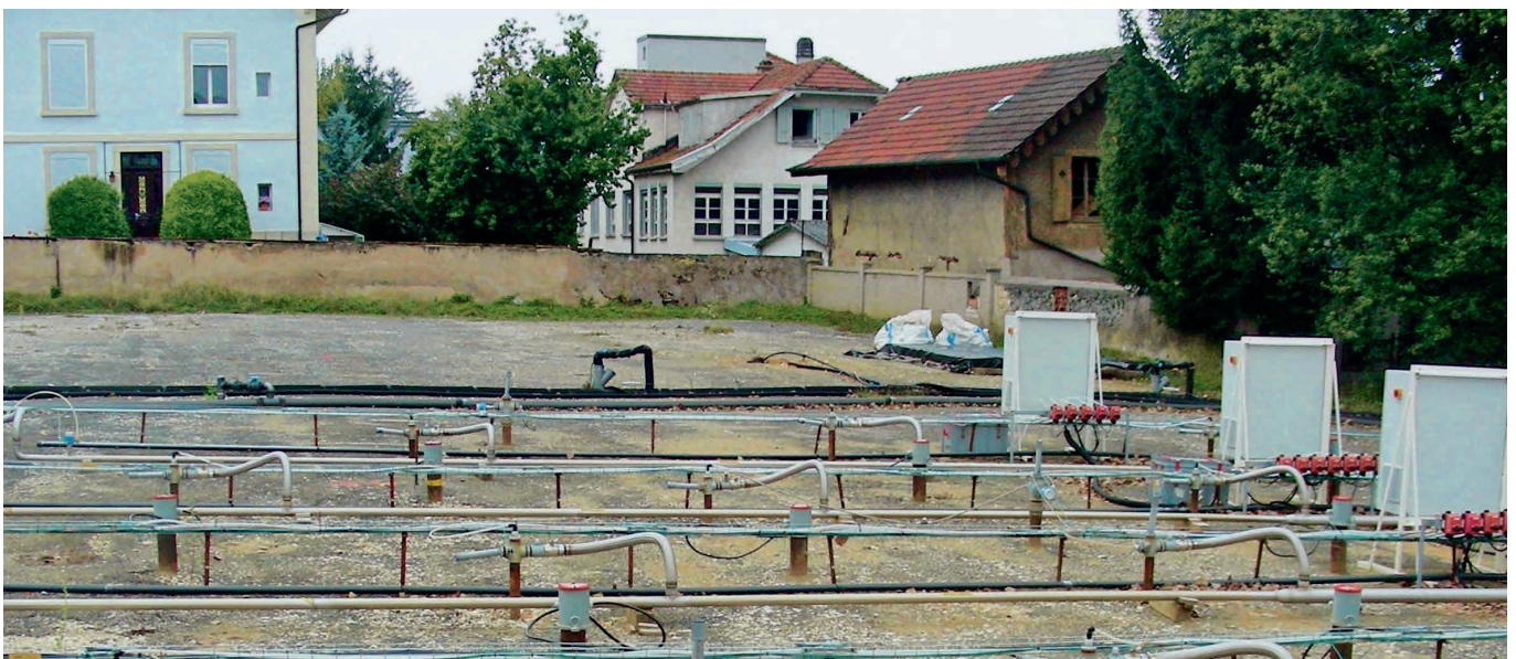
Abb. 29 In-situ-Sanierungen sind technisch oft aufwändig und erfordern viel Zeit – wie diese thermische Sanierung eines mit chlorierten Kohlenwasserstoffen verunreinigten Standorts.
