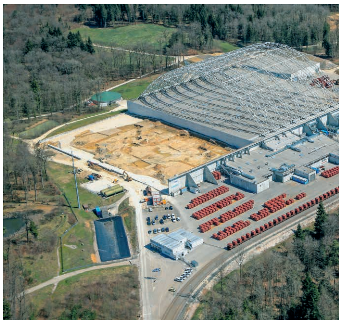
Abb. 35 Die Totalsanierung der Sondermülldeponie Bonfol (JU) begann 2010 – fast 35 Jahre nach ihrer Stilllegung.
