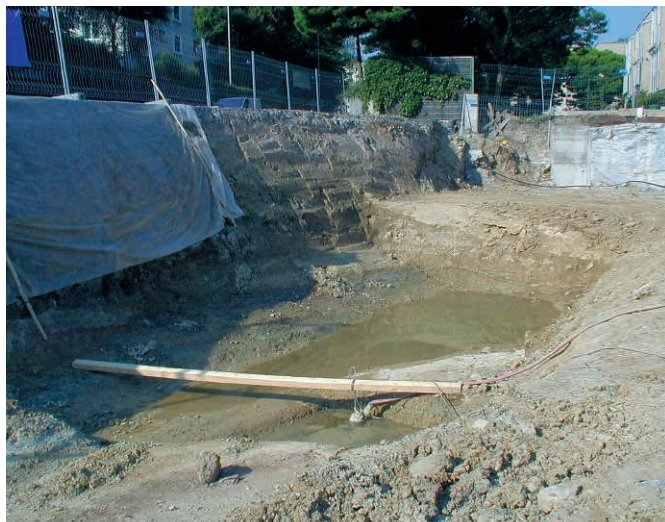
Abb. 47 Aus dieser Baugrube in Baden (AG) mussten rund 50 Tonnen Kohlenwasserstoffe entfernt werden – zum grössten Teil Rückstände von Benzin- und Ölunfällen.
