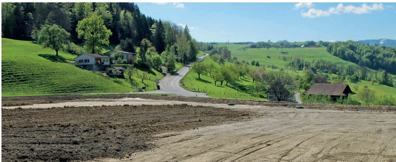
Abb. 41 Die inzwischen abgeschlossene Sicherung der Deponie umfasste auch eine Oberflächenabdichtung und fachgerechte Rekultivierung.
