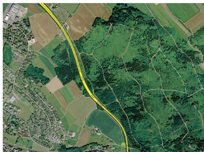
Abb. 17 Lang gezogener Standort Beim Bau dieser Strasse im Kanton Zürich kam mit Schwermetallen belastete Kehrriechtschlacke als Koffermaterial zur Stabilisierung des Untergrunds zum Einsatz. Diese Praxis war seinerzeit in der ganzen Schweiz erlaubt.
