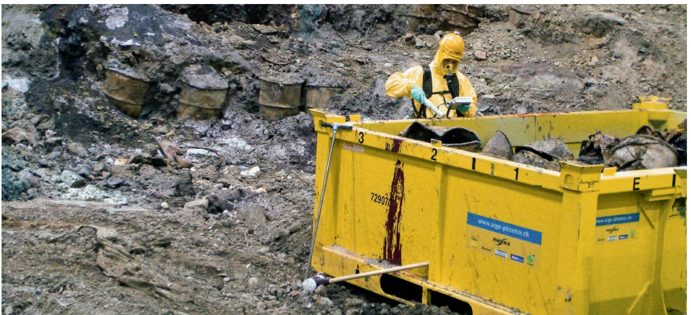
Abb. 48 Nicht nur technisch, sondern auch finanziell aufwändig: Kontrolle von ausgegrabenen Metallfässern in der Sanierungshalle der ehemaligen Sondermülldeponie Kölliken.
